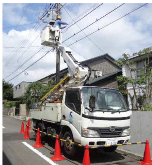
高所作業車での作業
