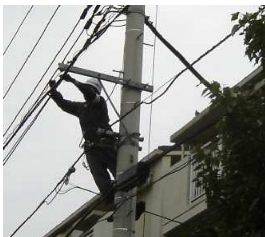
昇柱での作業
