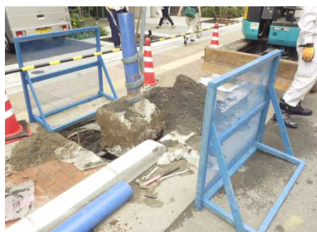
掘削土の飛散防止
