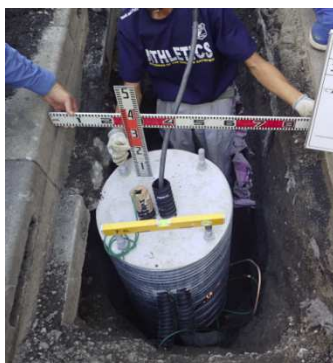
街路灯基礎の設置
