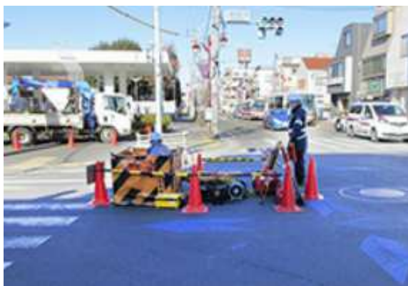
マンホールでの作業
