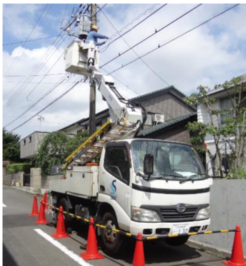
高所作業車での作業
