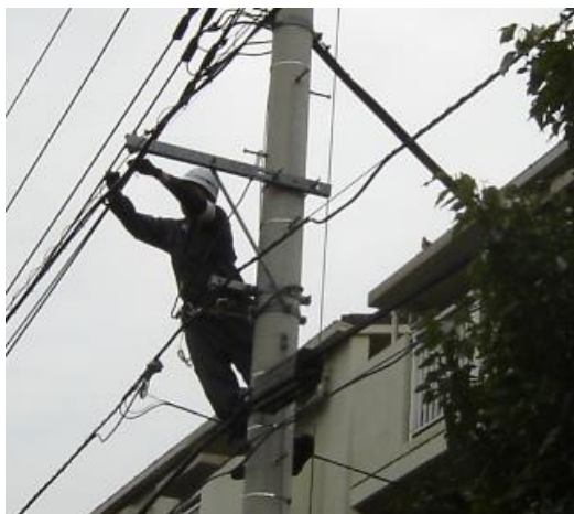
昇柱での作業
